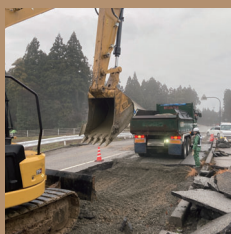
令和6年能登半島地震 応急対策工事
